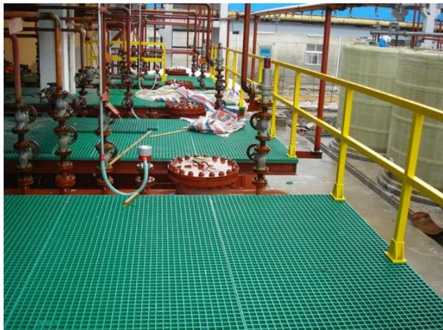
Напольные системы из пластика с армирующим стекловолокном специально разработаны для промышленных и общественных помещений, где особая важность уделяется защите от коррозионных воздействий. Уникальность GFK настилов в самом материале: известно, что стеклопластик обладает теплопроводностью дерева, прочностью стали, биологической, влаго и атмосферостойкостью полимеров и в то же время ему не свойственны недостатки, присущие термопластам.
