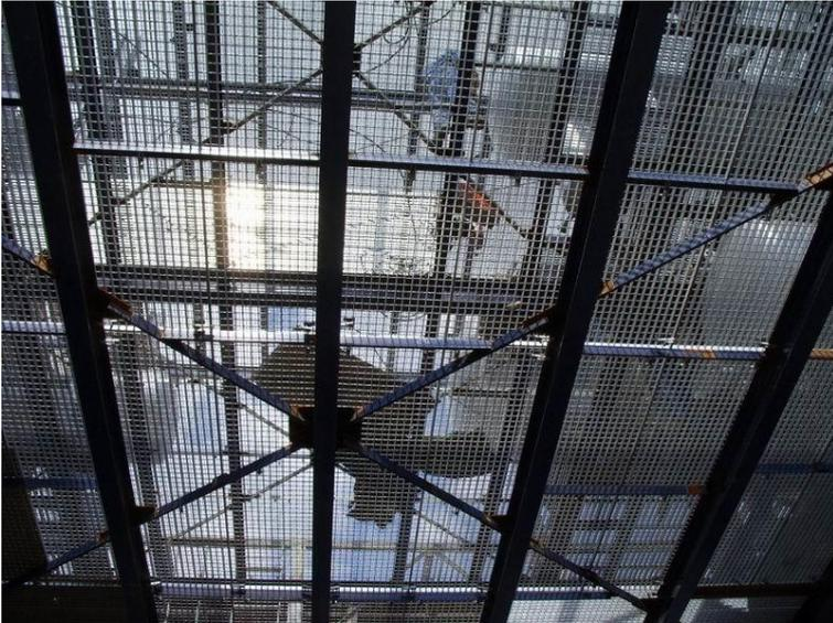
Данный тип настила изготавливается по DIN 24537-1 или ТУ 5262-001-60697912-2010 из свариваемой стали например S235 JR (аналог марки СТЗпс ГОСТ 380-94РФ или С235 ГОСТ 27772-88 РФ), St 52-3N (аналог марки СТ4 по ГОСТ 380-94 РФ) или любой другой стали согласно требованиям заказчика методом кузнечнопрессовой сварки. Настил производится без покрытия или с покрытием горячим цинком по DIN 50976 (EN ISO 1461) ГОСТ 9.307-89 РФ.
